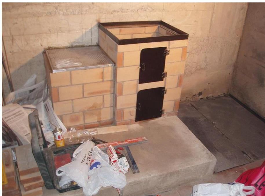
Ilustración 144 Construcción de horno refractario.
